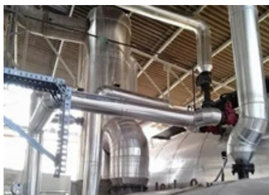
Slika 32. Fiksna izolacija cijevi [41]
