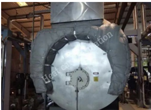
Slika 29. Odvojiva izolacija cilindričnog kotla [38]
