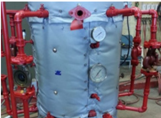
Slika 27. Odvojiva izolacija od kompozitnih materijala [36] Slika 28. Fiksna izolacija [37]
